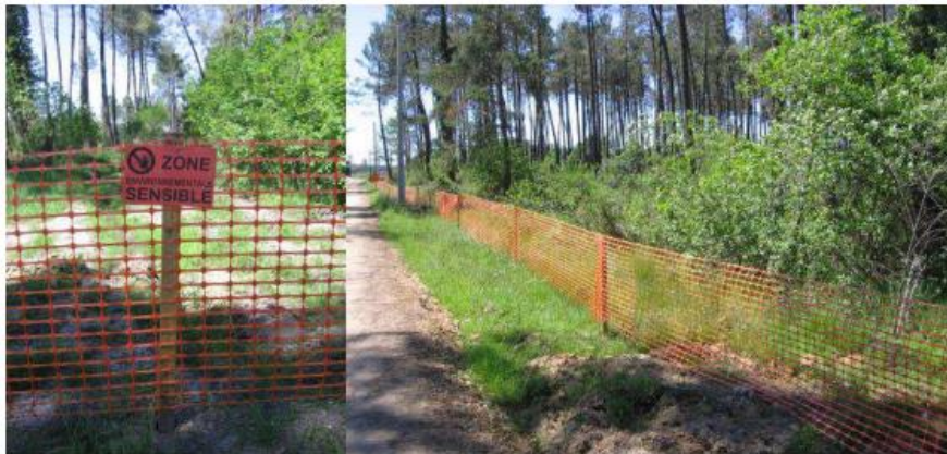
Exemple de mise en défens de zone sensible en phase chantier -
